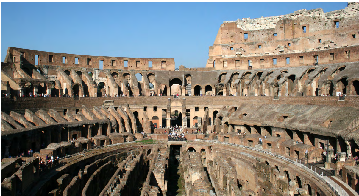
Abbildung 1: Unterkellerung des Kolosseums
