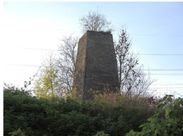
Abb. 19: Widerlager der Seilbahn von der Henrichshütte zur Zeche Friedlicher Nachbar (T. KASIELKE).
