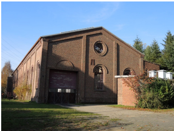
Abb. 18: Maschinenhalle von Friedlicher Nachbar (T. KASIELKE).
