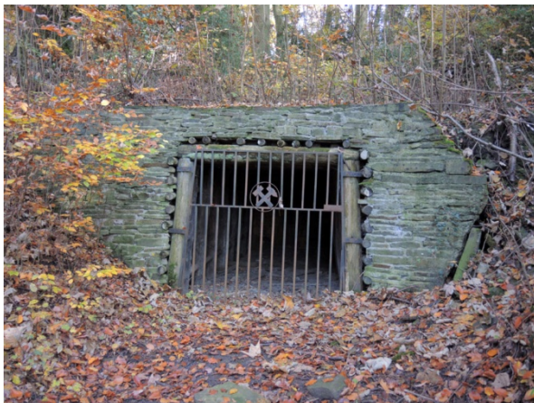
Abb. 13: Rekonstruiertes Stollenmundloch der Zeche Dickebaeckerbank (T. KASIELKE).
