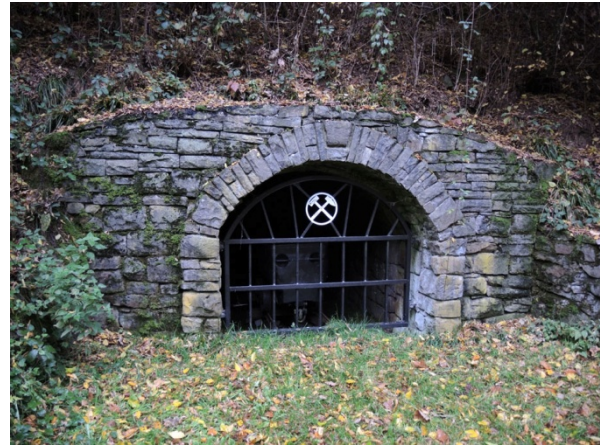
Abb. 16: Restauriertes Mundloch des St. Mathias Erbstollen II (T. KASIELKE).
