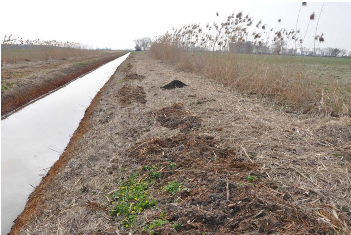
Abb. 4: Graben direkt nach Räumung. Bei der Räumung werden sowohl Pflanzen als auch Substrat aus dem Graben entfernt. Riedwiese, 27. März 2011, Foto Egbert Korte – View of a ditch (Riedwiese) immediately after being cleared, 27 March 2011. Vegetation and mud were removed during the procedure.
