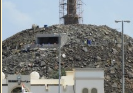
The Al Adwani Tower
