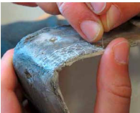
Abb. 5: Einritzen der Fugen
