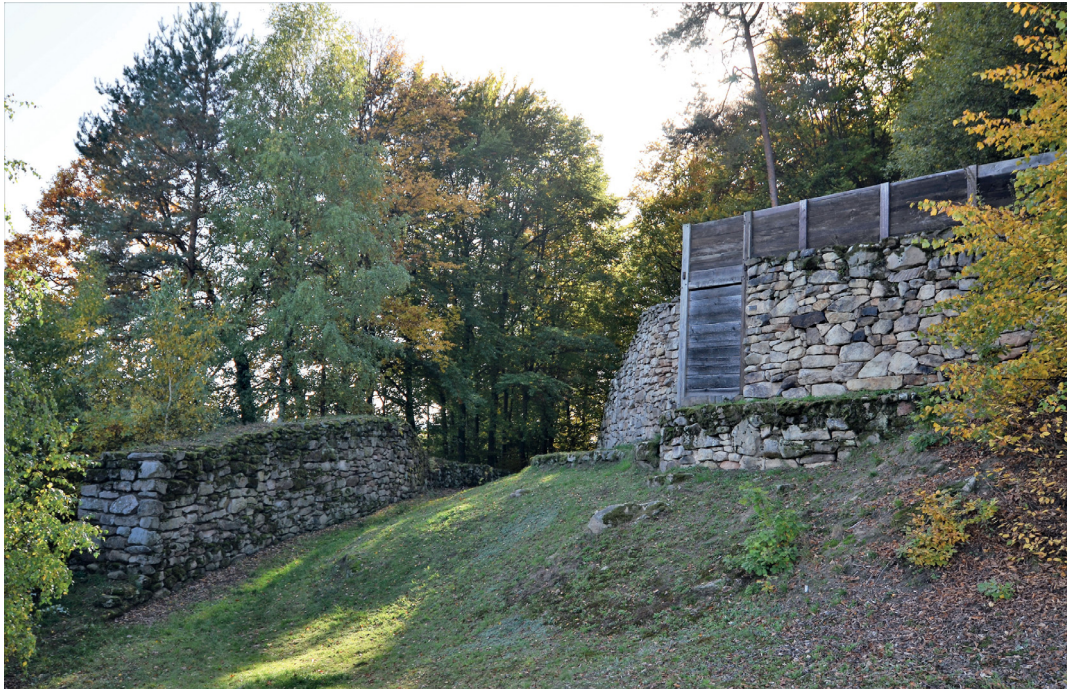
Abb. 12 Heunischenburg bei Kronach, Oberfranken. Rekonstruktion der spätbronzezeitlichen Befestigung mit dem zwingerartigen Tor der Periode III (Foto R. Krause)
