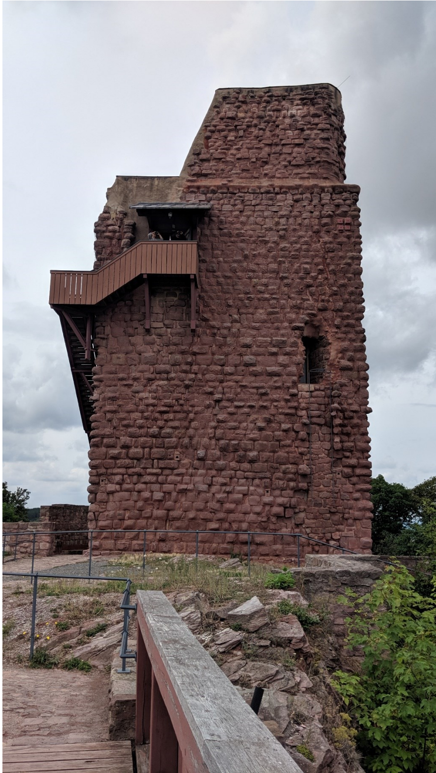
Abb. 2: Sogenannter „Barbarossaturm“ der Oberburg der Reichsburg Kyffhausen 155 .
