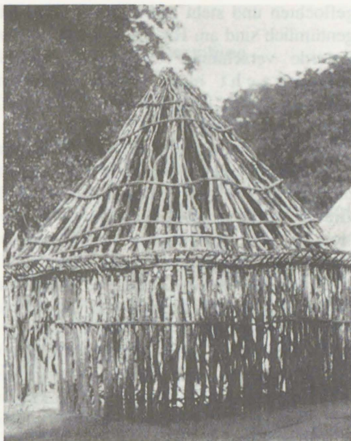
Foto 5: Hütte im Bau. Ndalla, 5.6.1913 [Schachtzabel 1926: Taf. 29 rechts]
