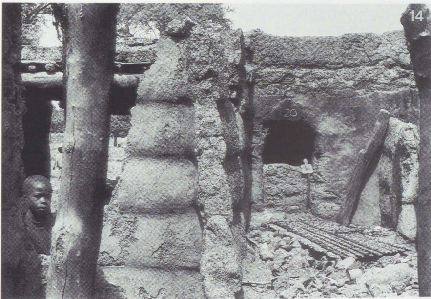
13 Le côté ouest de la maison en briques
