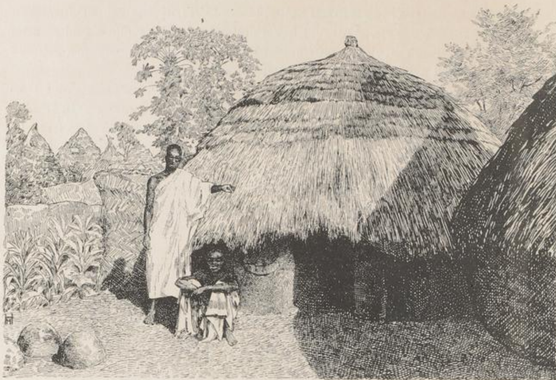
LEHMPLASTIK ALS STILBILDENDE VORBEDINGUNG DES KUPPELBAUES Kuppelbau im Jukumgebiet (Benue) mit Strohkappe. Nach Phot. v. L. Frobenius (DIAFE 1911) gez. v. H. Hagler
