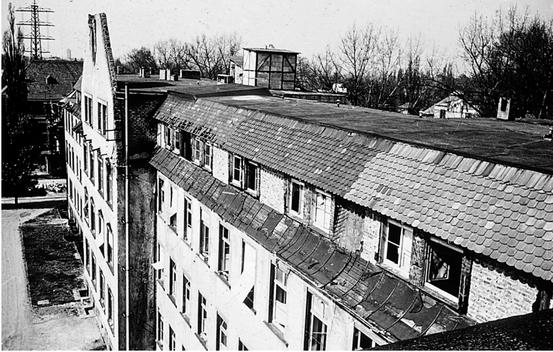
Südostfassade der Frauenklinik mit beschädigtem Dachgeschoss 1947 (Quelle: Sammlung Hosemann, Dr. Senckenbergisches Institut für Geschichte und Ethik der Medizin, Frankfurt am Main).
