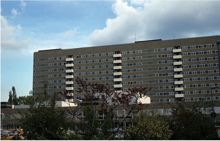
Zentralbau von Norden, September 1976 (Sammlung Hosemann).
