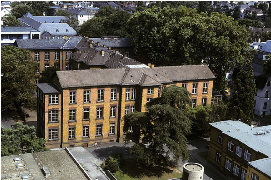
Die alte Hautklinik A (Haus 12) kurz vor dem Abriss 1980 (Sammlung Hosemann).
