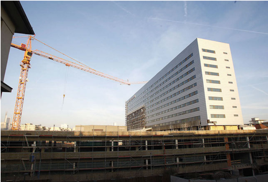
Der Zentralbau erhält 2009/10 eine neue Fassade (JÜ 2010, S. 12).
