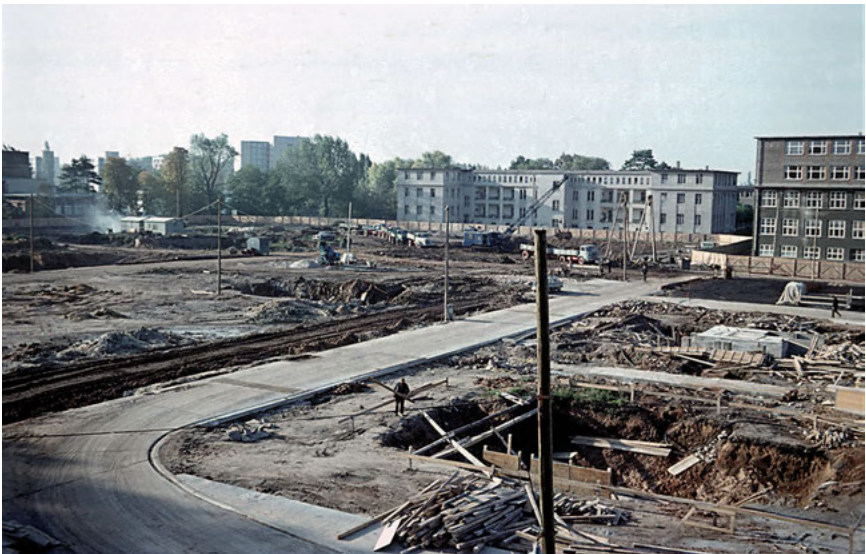
Beginn des Aushubs der Baugrube für den Zentralbau, September 1963 (Sammlung Hosemann).
