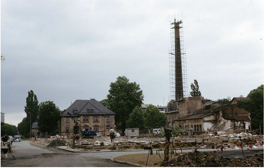
Abriss des Kesselhauses mit Schornstein (20.6.1963), um Platz für den Zentralbau zu schaffen (Sammlung Hosemann).
