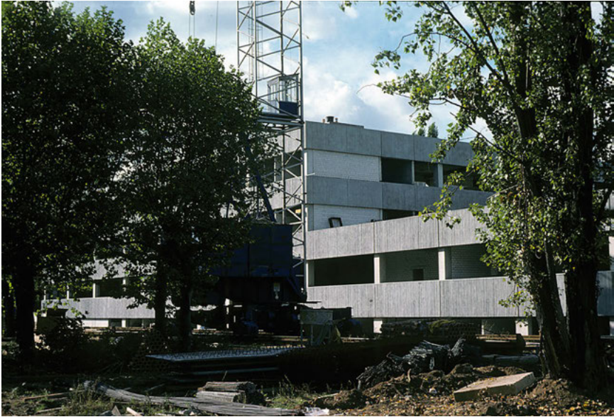
Robbau der Zahnklinik kurz vor dem Richtfest im September 1976 (Sammlung Hosemann).
