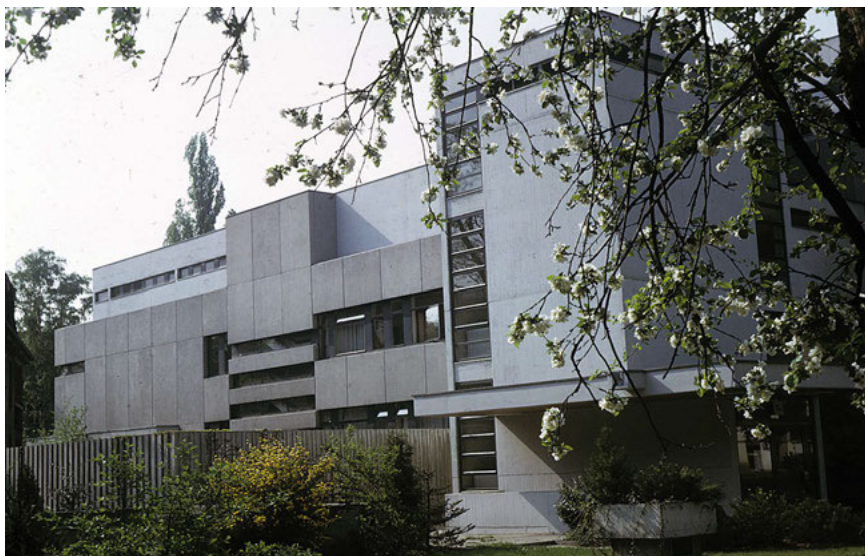
Funktionsbau der Frauenklinik (fertig 1971) 1974 von Nordosten (Sammlung Hosemann).
