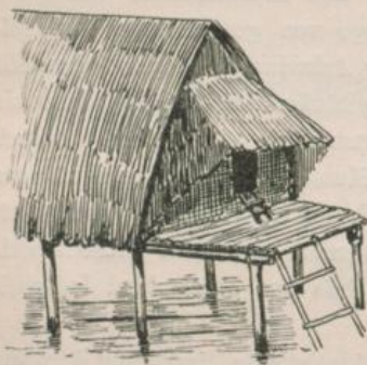
Fig. 201. Vorderseite eines Pfahlhauses in Kaire, Süd-Neuguinea (nach Finsch).
