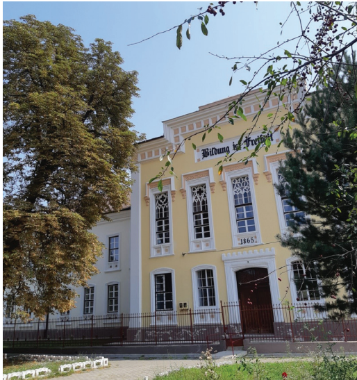
Abb. 1: Schulgebäude in Mühlbach (Fassade mit Spruch) 25
