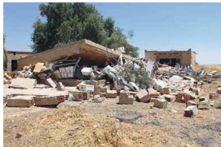
Das zerstörte Grabungshaus in Tell-Chuera (2015).
