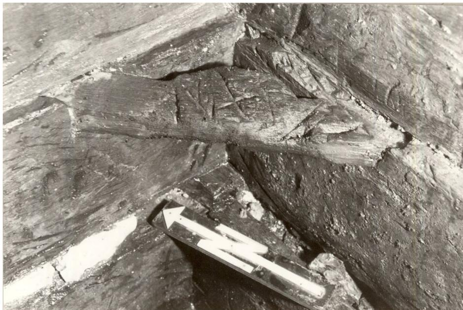
**Abbildung 126:** (O 51892); Eckversteifung des Brunnens (4029) mit Kerben
