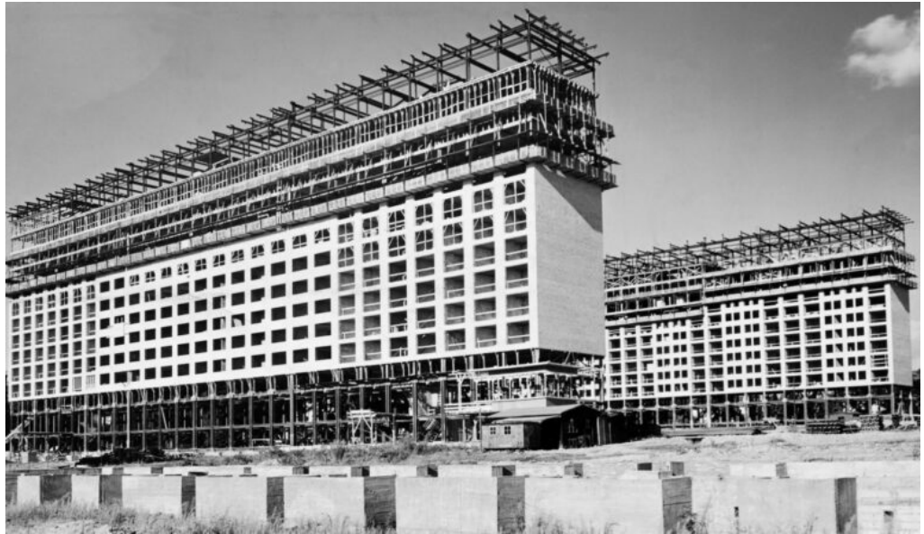
Hamburg Harvestehude: Bau der Grindelhochhäuser 20. August 1949, © Ullstein
