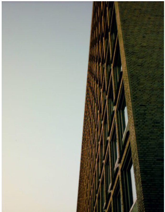
Die hell geklinkerte Fassade der Grindelhochhäuser
