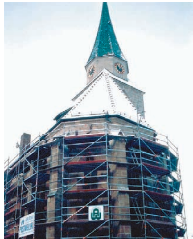
Abb. 9: Renovierungsarbeiten im Dezember 1996. Chor und Langhaus sind vollständig eingerüstet. Die Beton-Arbeiten am Turm erfolgen unter einem beheizten Zeltdach.
