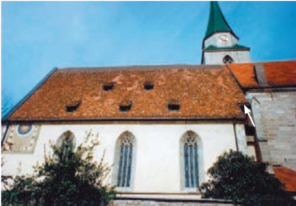
Abb. 1: Die Kirche St. Michael in Entringen (Kreis Tübingen): Südseite mit Turm. Weißer Pfeil rechts: Ein- und Ausflugöffnung für die Fledermäuse.
