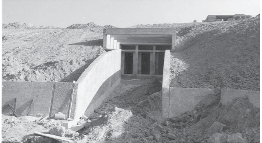
Der Erdbunker für explosives Nitrofilm-Material war bereits Teil des Neubaukonzepts.
