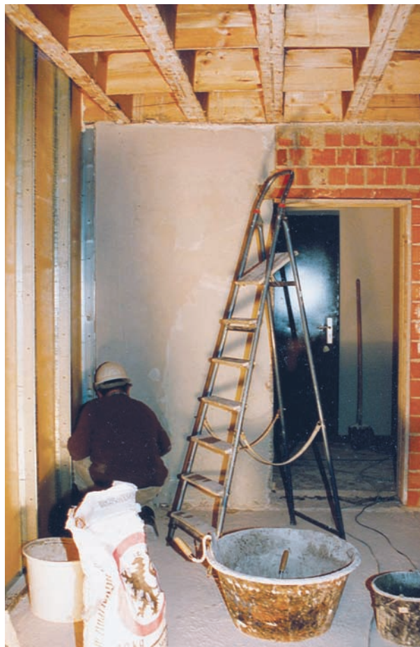
Der große Umbau 1993 im Rahmen der Kapazitätserweiterung: Zwischendecken werden eingezogen und Platz für moderne Studios sowie eine digitale Infrastruktur geschaffen.
