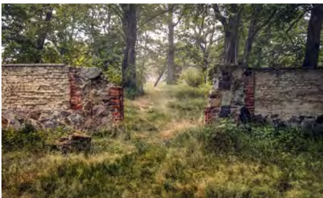
Die Lücke in der Mauer markiert den ehemaligen Torein- gang des Friedhofs
