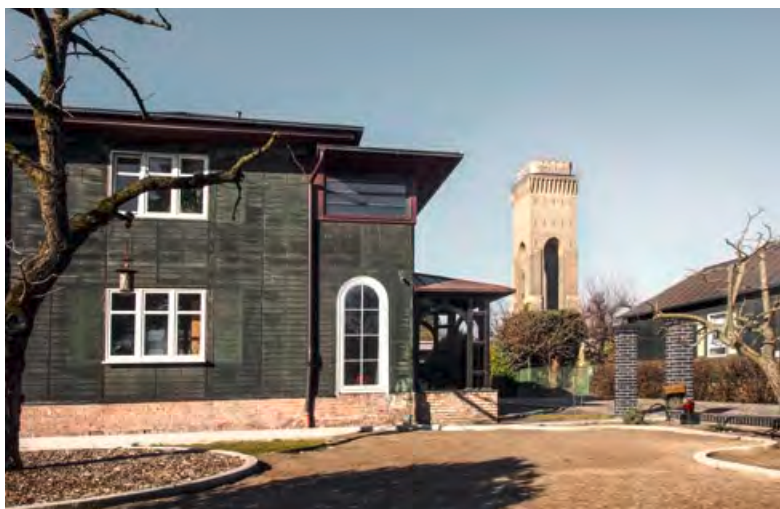
Oben: Das Fragment der Torarolle im Gedenkraum mit zwölf Kolumnen aus dem 1. Buch Moses, der Genesis. Unten: Kupferhaus in der Mustersiedlung; im Hintergrund der 1917-18 erbaute Wasserturm, das Wahrzeichen des Finowtales
