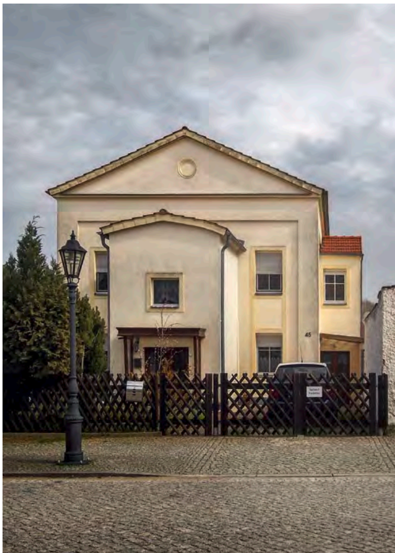
Vorherige Seite: Eingangstor und Innenhof des Friedhofs Oben: Das ehemalige Synagogengebäude in der Brandstraße
