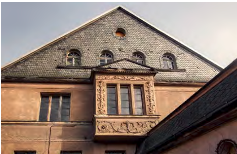
Vorherige Seite: Der Finower Wasserturm von unten. Oben (von links nach rechts): Villa Hirsch, Altes Hüttenamt und Torbogenhaus. Unten: Giebelseite der Villa Hirsch mit Erker. Rechts: Fries mit den Symbolen der Familie – Hirsch und Levitenkanne
