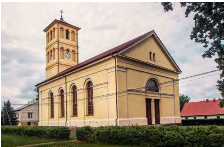
Vorherige Seite: Sanssouci jenseits der Oder – das Schloss in Glińsko 2021. Oben: Eine Lithografie zeigt Schloss und Kurbad zur Mitte des 19. Jahrhunderts. Unten: Die Schinkel-Kirche von Glińsko steht heute unter Denkmalschutz
