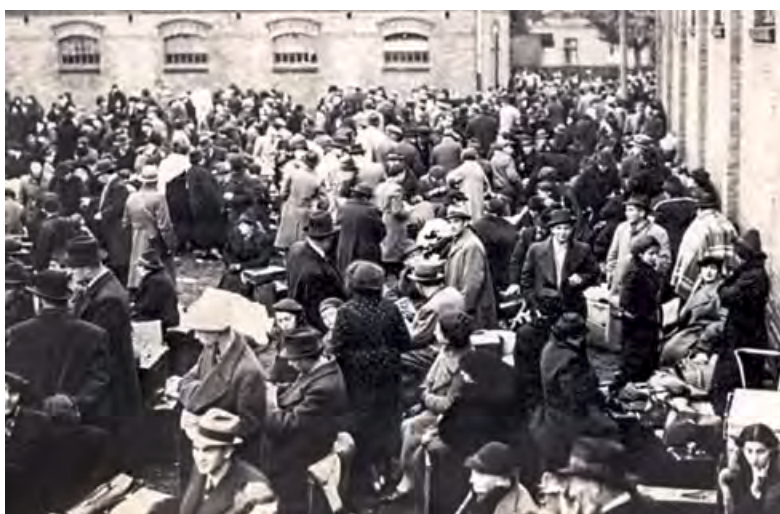
Vorherige Seite oben: Der 1929 errichtete neue Bahnhof von Zbąszyń. Unten: Bahnhofsgebäude aus dem 19. Jahrhundert. Diese Seite oben: Suppenausgabe im November 1938. Unten: Deportierte der »Polenaktion« auf dem Hof einer ehemaligen Kaserne
