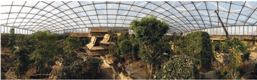
Abb. 6. Panoramabild von der Baustelle der Riesentropenhalle Gondwanaland im Zoo Leipzig, Rohbau fertig, Innenausbau etwa halbfertig 50
