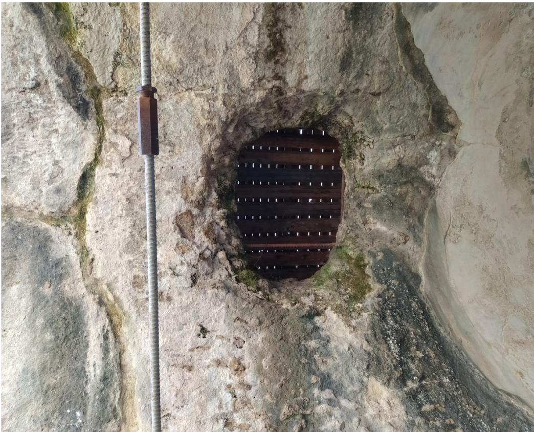
**Fig. 6** Foro effettuato nella 3° volta del II° livello dagli scavatori del '700 delle Grandi Sostruzioni (foto: C. Mocerino).
