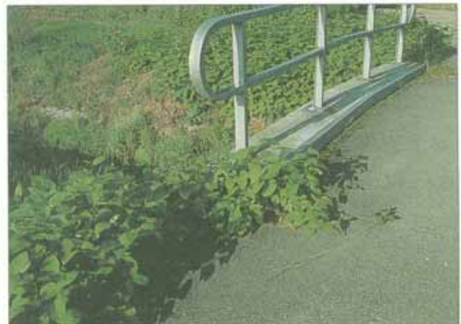
Abb. 16: Japan-Knöterich wächst in einer Fuge zwischen Brücke und Rampe (Kamm bach zwischen Offenburg und Sand)
