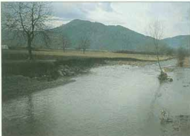
Abb. 10: Hochwasserschadbild auf Befallsflächen des Japan-Knöterichs am Erlenbach (Ortenaukreis) in typischer Tropfenform der Auskolkung. Ähnliche Schadbilder wurden z.B. auch an Rench und Kinzig dokumentiert. Diese Schäden können sehr wahrscheinlich mit den Knöterich-Beständen in Verbindung gebracht werden.
