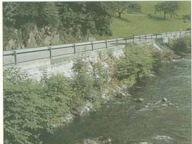
Abb. 20: Japan-Knöterich in mörtelverfugtem Böschungspflaster (Wolf bei Oberwolfach)
