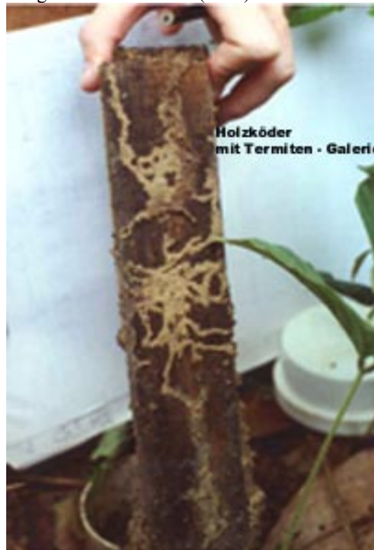
Abbildung 16: Ködersubstrat (Holz) mit Termiten-Galerie
