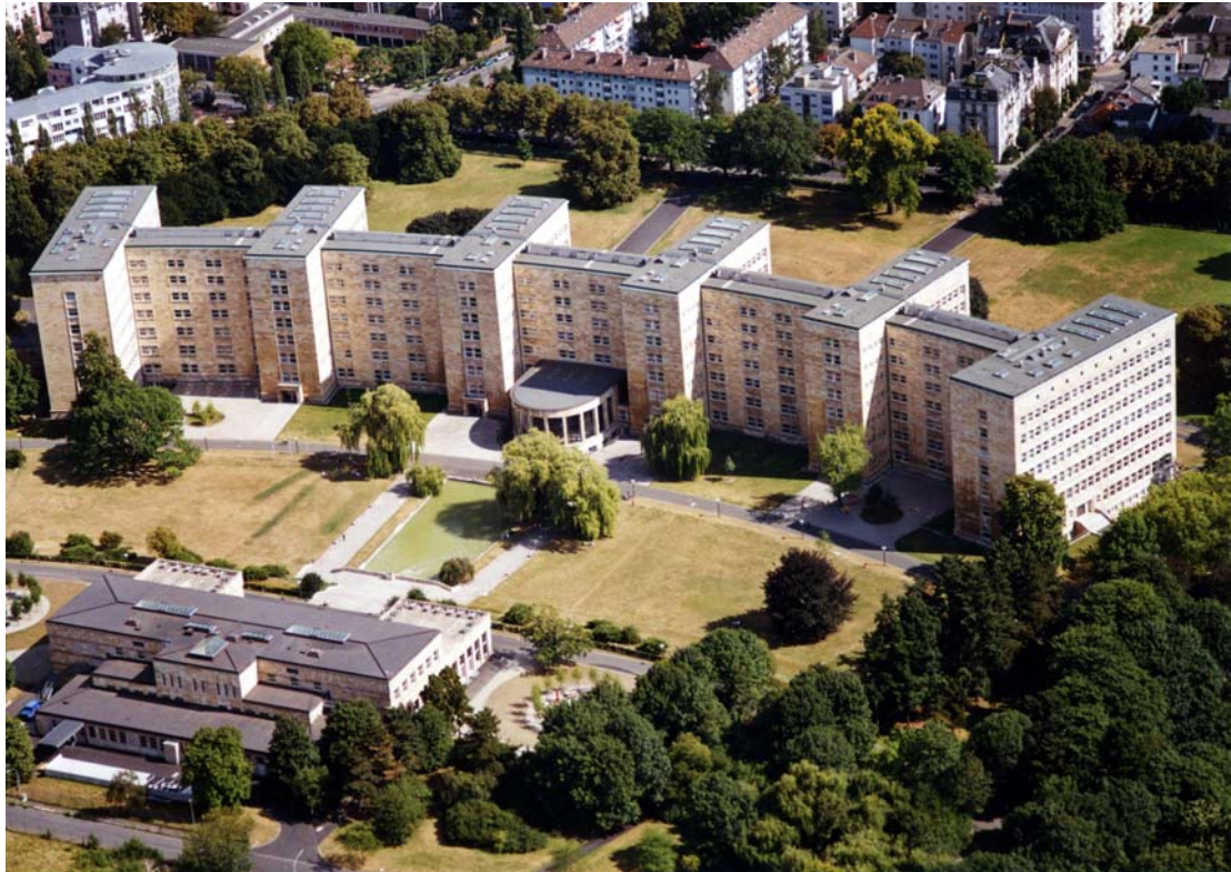
Poelzig-Bau in Frankfurts Westend (Sicht von Nordwest)
