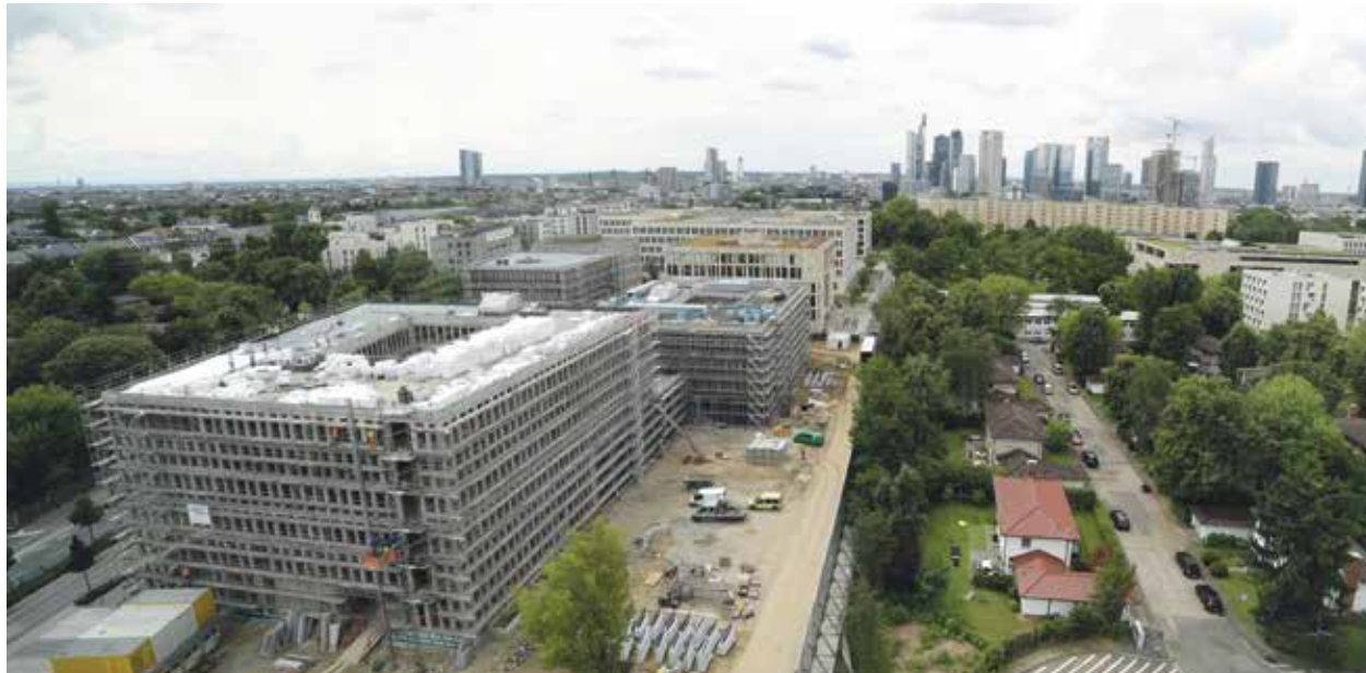
Blick vom DIPP auf den Rohbau des SKW. Im Hintergrund (rechts) ist das IG-Farben-Haus vor der Skyline Frankfurts zu sehen. Foto: Dettmar
